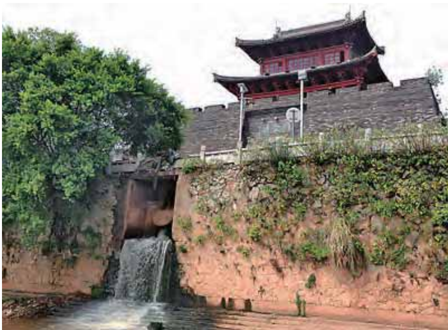
福寿沟排水口
