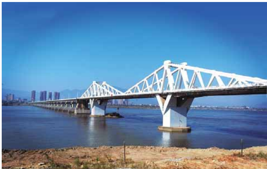
福州洪塘大桥
