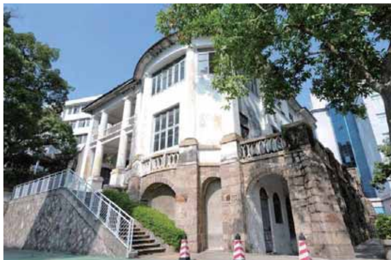
美国驻福州领事馆办公楼
