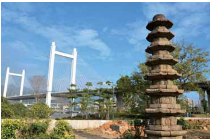
绍岐石塔与魁浦大桥
