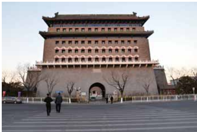
修复后的正阳门箭楼
