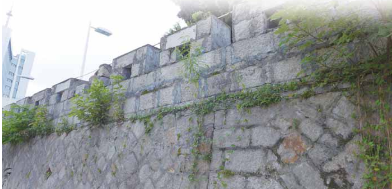
以“丁顺砌法”砌成的城墙
