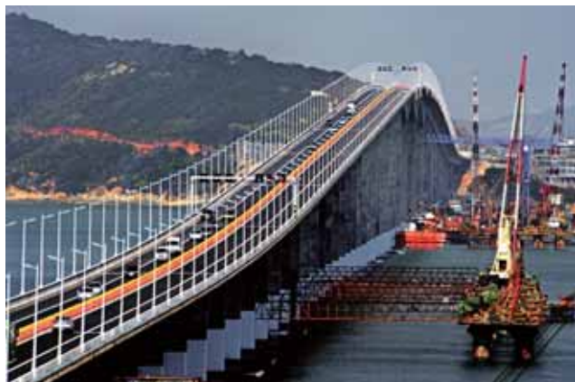
2007年11月30日，平潭海峡大桥正式开工建设。
