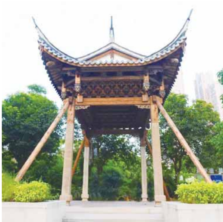
修复后的茶亭庵四角亭
