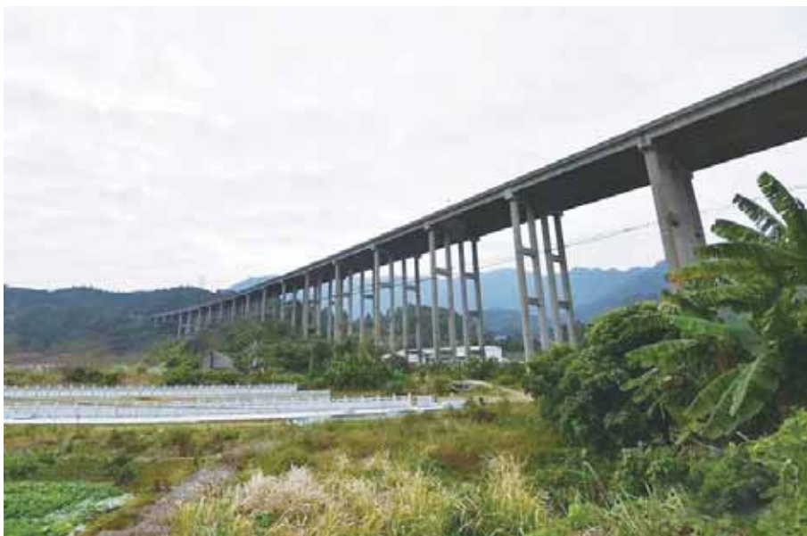
穿过东台村的尤树特大桥
