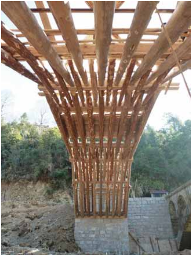
2014年1月重建谢坑进贤桥（水尾桥），可以看见独特的“编木结构”
