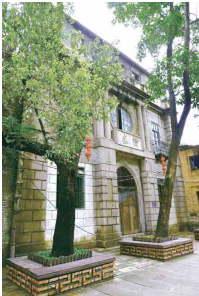
上杭路恒盛布行旧址
