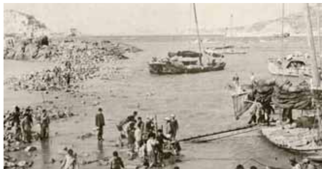
马鼻公社工人在抛石垫层施工
