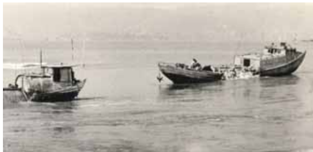
蝴蝶船抛石施工作业
