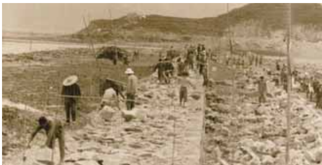
九号堤施工现场
