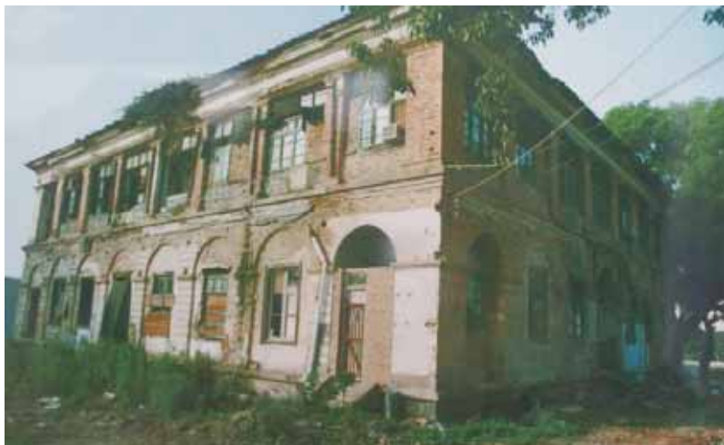
修复前的汇丰银行大楼
