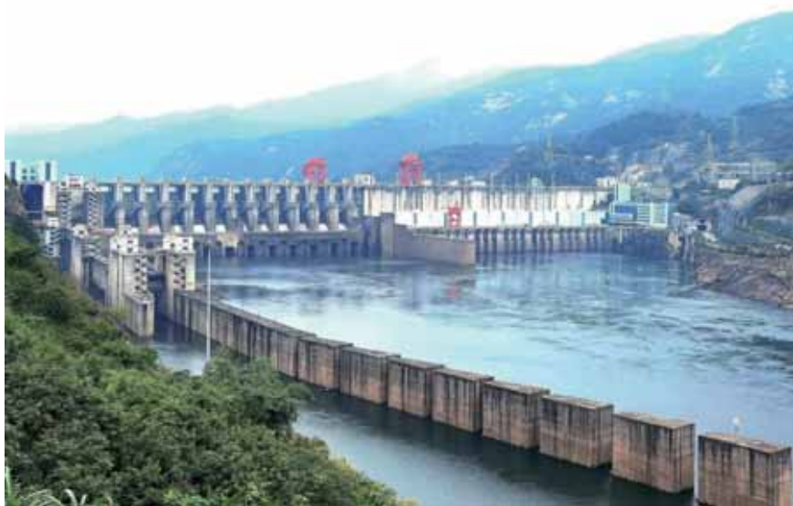
水口水电站大坝
