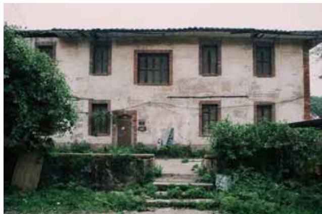
修缮前的荷园
