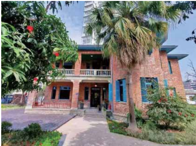
荷园修缮后的新貌
