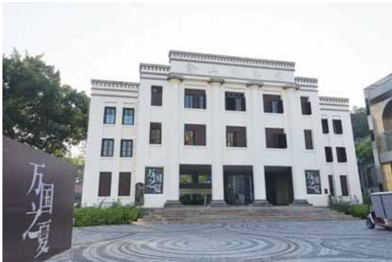
荷兰驻福州领事馆旧址
